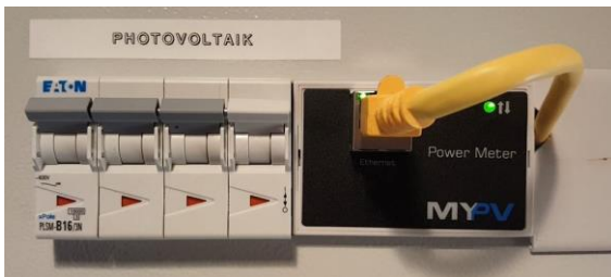
Abbildung: Der Power Meter wird direkt nach dem Zähler des Energieversorgers im Verteilerschrank montiert.
