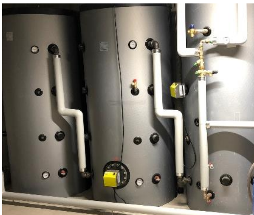
Abbildung 1: Zwei AC ELWA-F in den Pufferspeichern erzeugen Wärme aus PV-Überschuss
