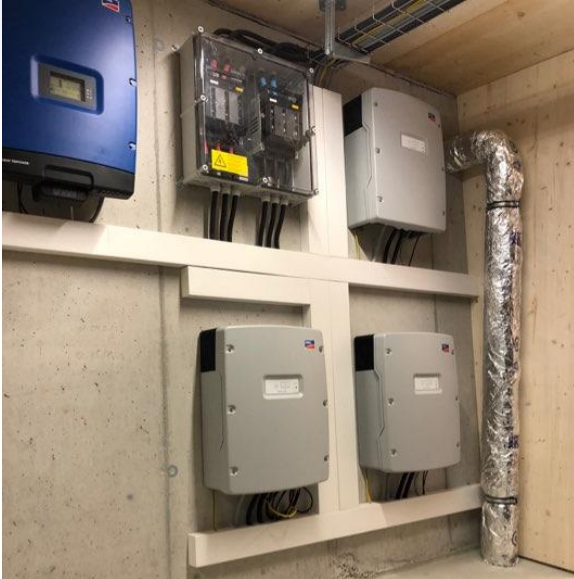
Abbildung 3: Der Batteriewechselrichter SMA Sunny Island gibt durch die Netzfrequenz die Leistung zur Wärmeerzeugung vor
