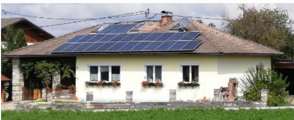
Abbildung 1: In diesem Einfamilienhaus sorgt der AC•THOR 9s von my-PV für maximalen PV-Eigenverbrauch durch photovoltaische Warmwasserbereitung und Heizungsunterstützung
