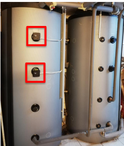
Abbildung 2: Der AC•THOR 9s PV-Leistungssteller macht die Standardheizstäbe „photovoltaiktauglich“
