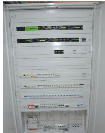
Der Loxone Miniserver im Schaltschrank erkennt mittels Energiezähler die Überschüsse und sendet das Steuersignal per Netzwerk an die AC ELWA-E von my-PV.
