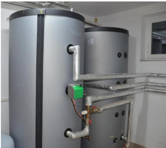
Die AC ELWA-E wurde mittig im 1.000 Liter Pufferspeicher eingebaut und wird bei Stromüberschuss stufenlos geregelt.
