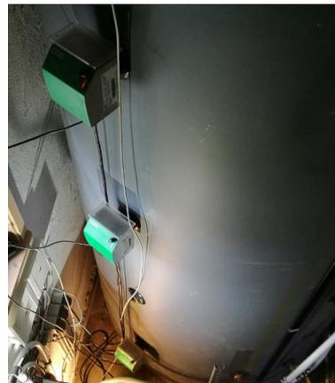
Die drei AC ELWA-E sind auf verschiedenen Höhen im Pufferspeicher montiert.
