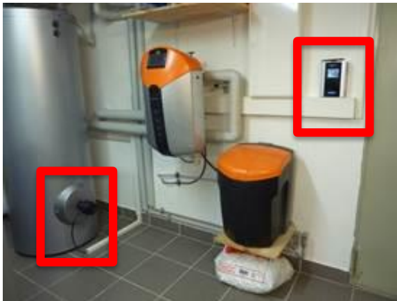
Abbildung 2: Der AC•THOR PV-Leistungssteller macht den Standardheizstab „photovoltaiktauglich“
