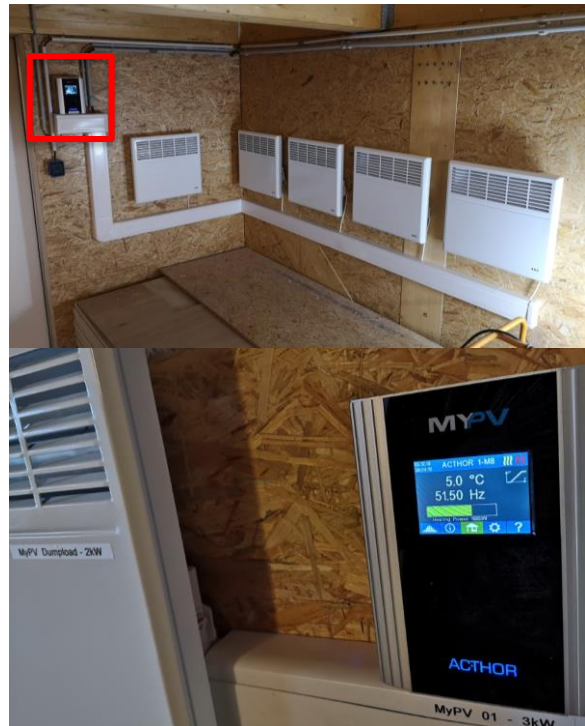
Abbildung 3 und 4: AC•THORen für Raumwärme
