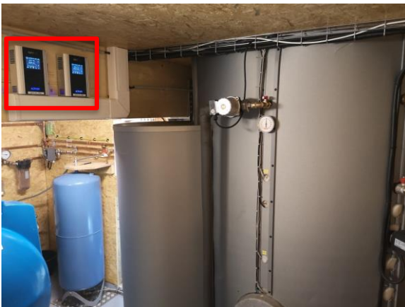
Abbildung 2: AC•THORen zur Warmwasserbereitung
