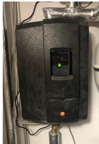
Der AC•THOR 9s macht die Hydraulikeinheit Tuxhorn tubra eTherm C (rechts) stufenlos regelbar und somit „PV-ready“.
