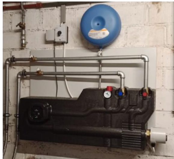
Hydraulische Schichtladeeinheit mit einem 6kW Heizelement.
