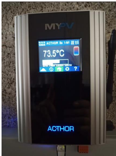
Der AC•THOR 9s erhält das Steuersignal direkt vom RTC Power Wechselrichter über das Netzwerk.
